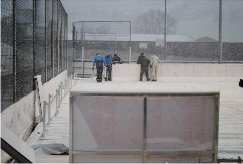
Bildlegende: Aufbauarbeiten für den "Eispark Erlenmoos" in Wollerau
